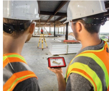
Digitaal maatvoeren en traditioneel boren
